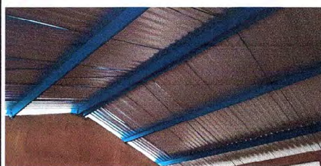
Foto 4: FINALIZACION DE MANTENIMIENTO DE ESTRUCTURAS
