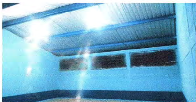
Foto 3: FINALIZACION DE MANTENIMIENTO DE INSTALACION DE ENERGIA ELECTRICA
