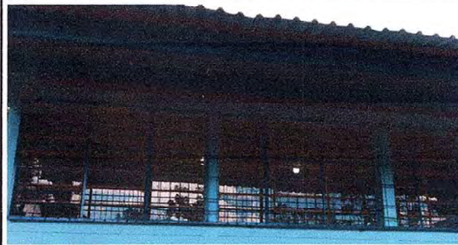
Foto 2: FINALIZACION DE MANTENIMIENTO DE VENTANAS, BALCONES Y VIDRIOS
