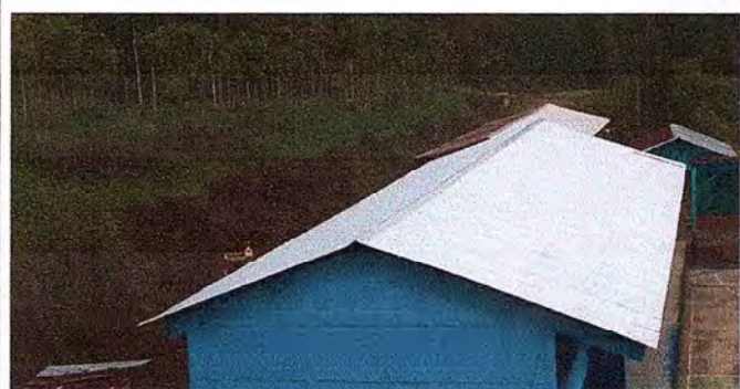
Foto1: FINALIZACION DE SUSTITUCION DE LAMINAS POR LAMINAS TROQUELADAS
